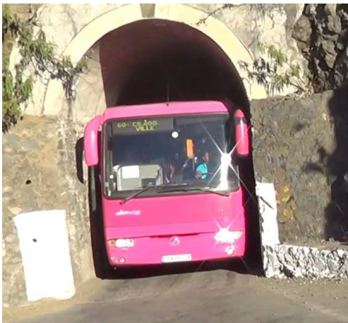
Figure 2: Tête de tunnel nord côté Cilaos
